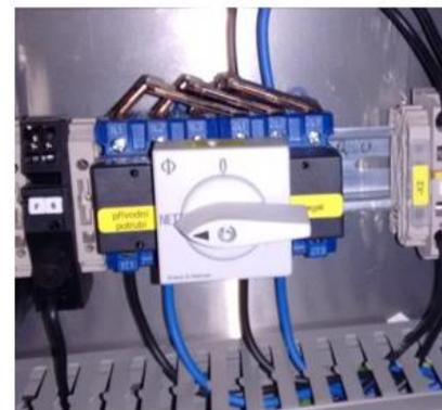
Obr. 1: Přepínač síťového napájení
