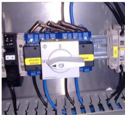
Abb. 1: Umschalter Netzversorgung
